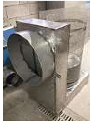
VALVOLA DI USCITA per prima pioggia in continua valvola in uscita
